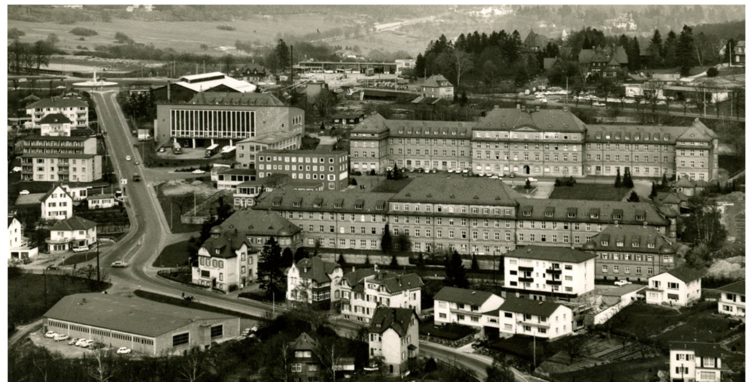
Die englischen Kasernen der 20er Jahre dominieren bis heute den Hang entlang der Wiesbadener Straße. Blick auf die Kasernen und das neu erbaute 'Haus der Begegnung' Anfang der 60er Jahre des 20. Jahrhunderts (oben).
