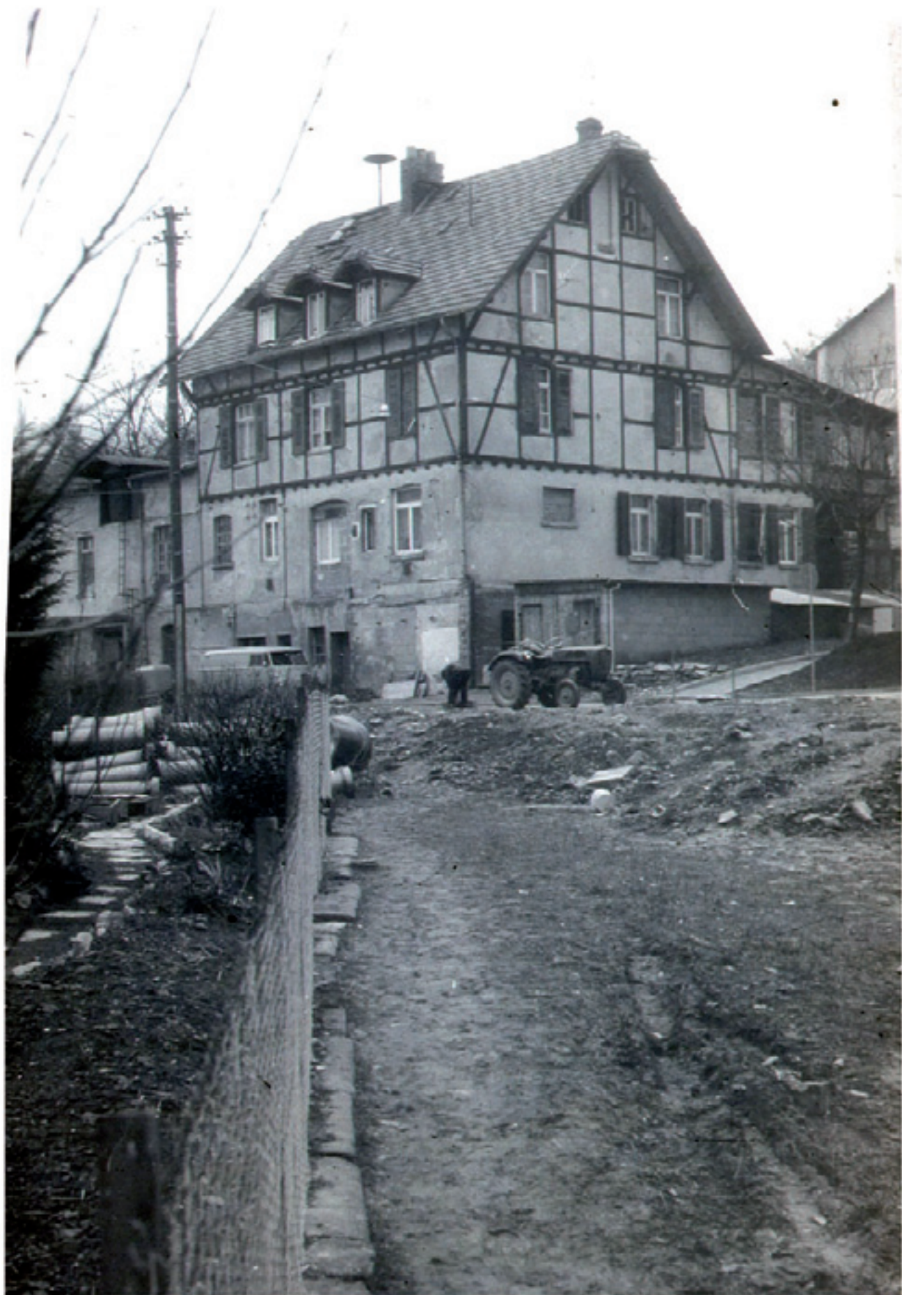
Das Gebäude des Städtischen Wirtschaftshofes 1968: Lagerort der undokumentierten Reste der städtischen Museen „Heimatsmuseum“ und „Burgmuseum“ bis 1968.
